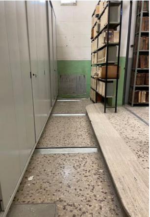
Foto 37 e 38 - Dislivelli scaffale compatto deposito n. 48
